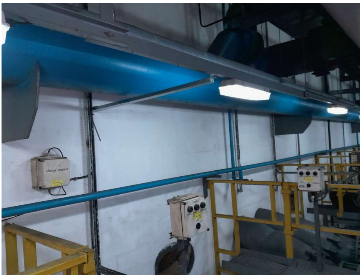
fot.4_ Widok ścian komór filtracyjnych (od strony galerii rurociągów)
