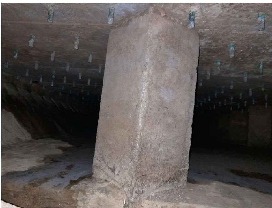
Fot.3_ Widok na przestrzeń między denną komory filtracyjnej (płyty drenażowe, słupki betonowe podtrzymujące płyty, dno filtra)
